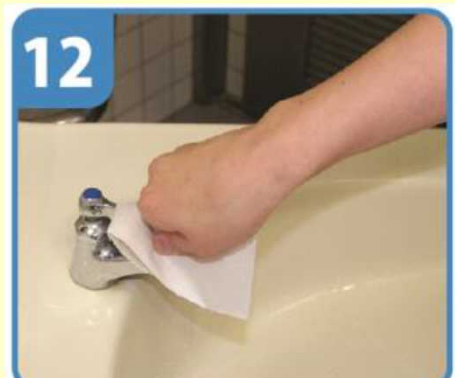
蛇口栓にタオルをかぶせて 栓を締める
